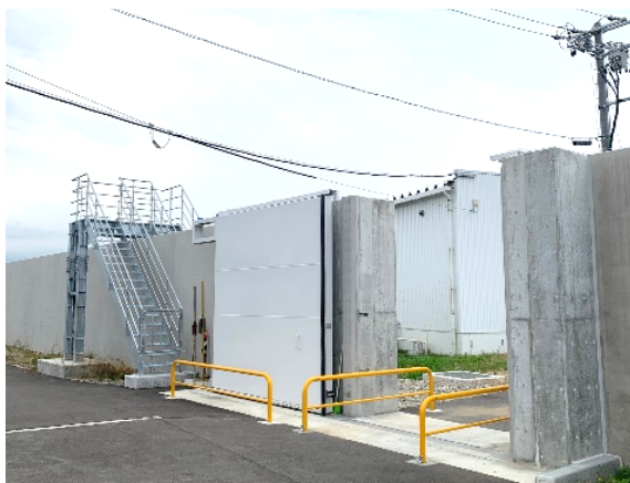
階段を設置し、止水扉閉鎖時の出入りを確保。
