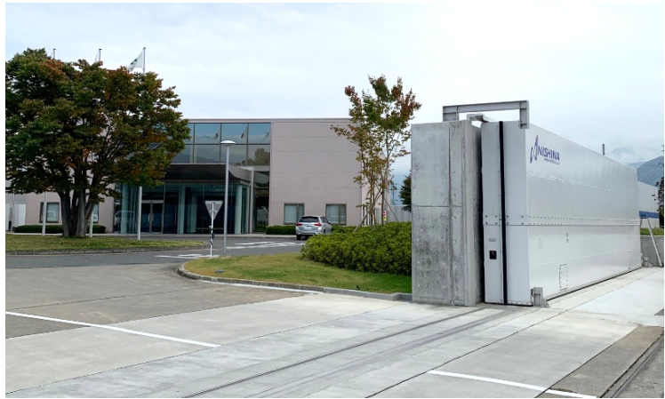
・正面入口 止水扉は手動開閉式で、閉鎖に約20分かかるとの事。
