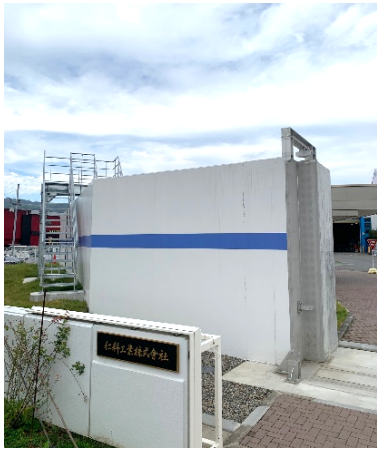
・正面入口 止水扉は手動開閉式で、閉鎖に約20分かかるとの事。
