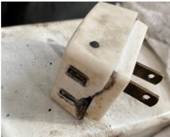
たこ足配線により焼損した電源タップ
