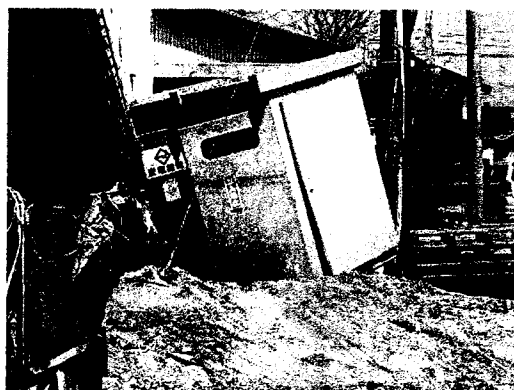
自家用受電設備の被害
