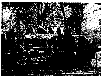
仮設移動変台
