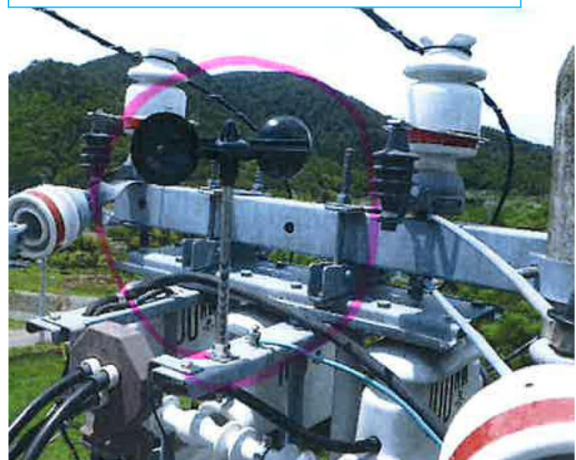
鳥害対策品(一で囲んだ範囲)取付後
